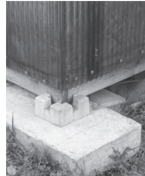
束石の上に土台を渡していたが、強度を増すためコンクリートを打設して束石をつなぎ合わせた
