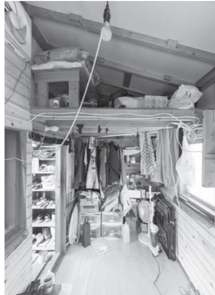
出入口の上には、ロフトを設置。片流れ屋根との間のスペースを物置とし、下も収納としている
