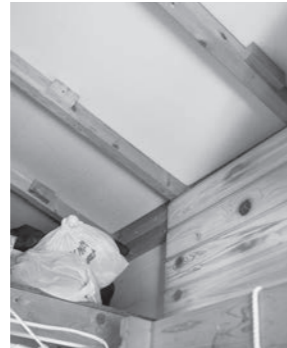
壁は当初は天井面と同じように断熱材が現しであったが、フローリング用の板材を譲り受けて張った
